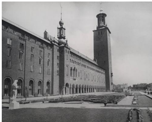
Hôtel de ville de Stockholm, façade donnant sur le lac Mälär. Arch. Ragnar ÖSTBERG (1911-1923). J. ROOSVAL dir., Stockholms Stadshus, Stockholm, Gunnar Tisells tekniska förlag, 1923. Paris, Bib. Nordique.
