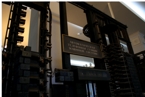
Centraux téléphoniques automatiques soviétiques montés à l'usine Aurore rouge (ancien Ericsson) dans le cadre du contrat d'aide technique avec Ericsson (fin des années 1920).
