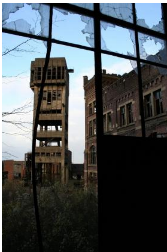
Charbonnage du Hasard, Cheratte. L'état de conservation du site témoigne de l'emprise irréversible du temps et des droits repris par la nature, Belgique. © Marina Gasnier, 2013.
