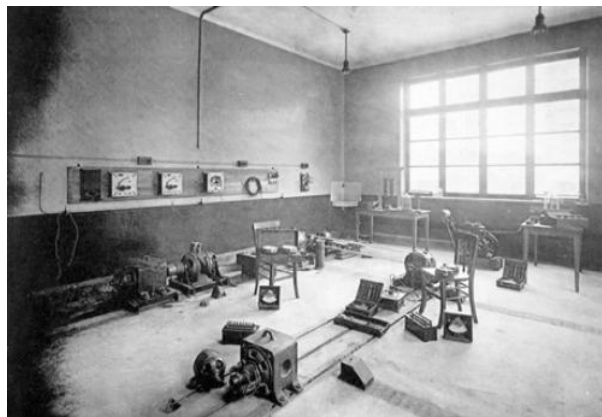
Laboratoires d'essais et de mesures électriques de l'école professionnelle de l'Est (1928). Au cours du xx e siècle, l'établissement éponyme fondé par Henri Loritz est tour à tour une école nationale professionnelle, un lycée technique et un lycée général et technologique. Il abrite aujourd'hui un centre de formation des apprentis avec des sections de techniciens supérieurs et des licences professionnelles. Source : Réseau Canopé.
